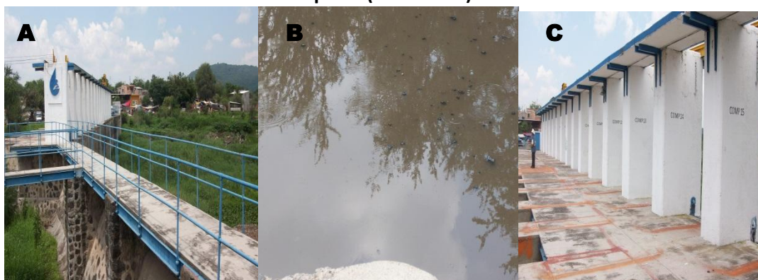
Imagen 8. Presa Poncitlán. a) Infraestructura de la presa, b) Contaminación en la presa, c) Compuertas de la presa (20 en total).
